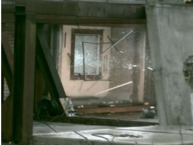
Bild 1 Bersten eines einfachen Fensters nach einer Explosion (Quelle - Kinon Porz / Saint-Gobain)
